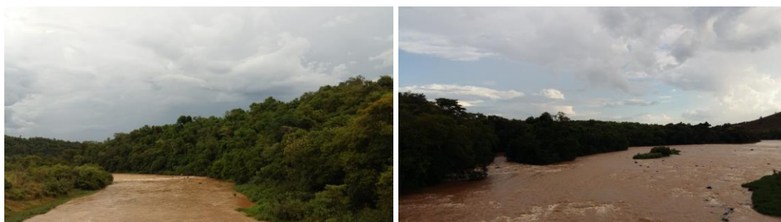
FIGURA 6: Ponte sobre o Rio Laranjinha, entre Santa Amélia e Cornélio Procopio
