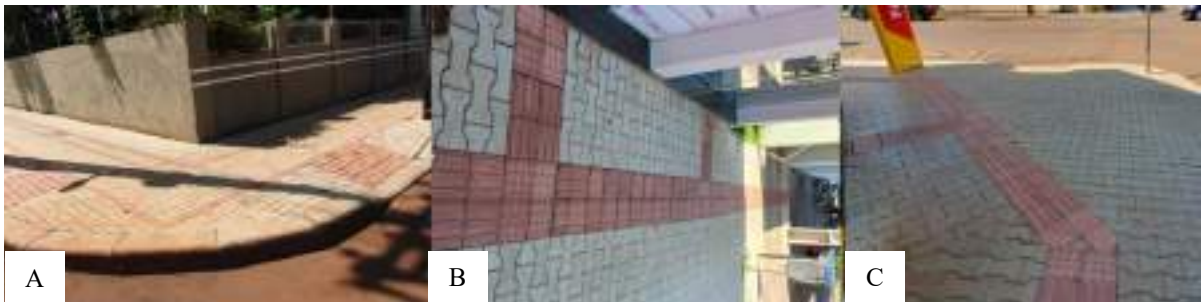
Figura 7 – Trecho 02 – Medidas de Acessibilidade.
