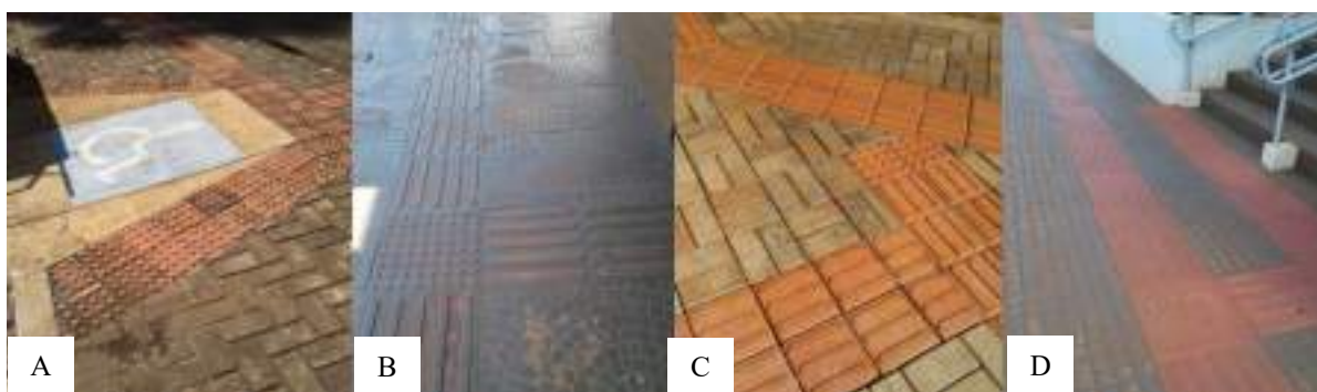
Figura 5 – Trecho 01 – Medidas de Acessibilidade.
