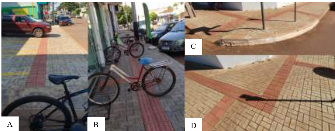
Figura 9 – Trecho 03 – Medidas de Acessibilidade.
