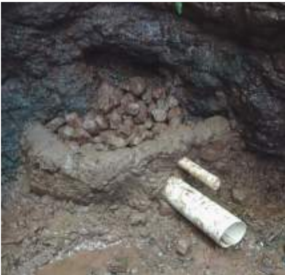
Figura 2: Proteção da nascente utilizando a técnica solo-cimento.
