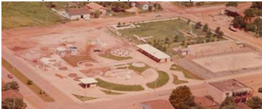
Figura 5 - Construção e instalação de equipamentos na Praça das Flores na década 1970
