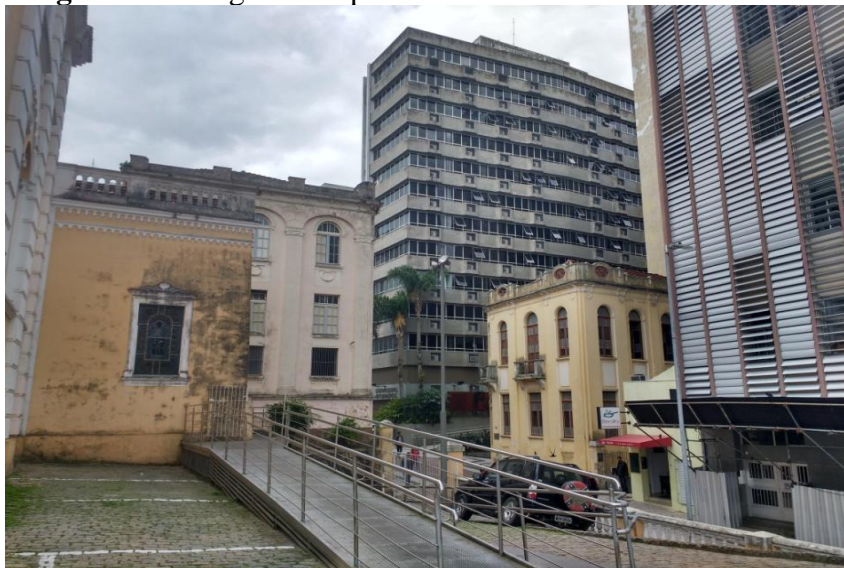
Figura 1 - Fotografia de parte da fachada da Casa da Memória
