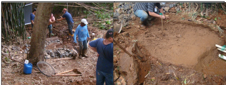
Figura 3A - Nascente sendo protegida por meio da técnica do solo-cimento com participação dos agricultores na forma de mutirão no município de Barbosa Ferraz no ano de 2017.
