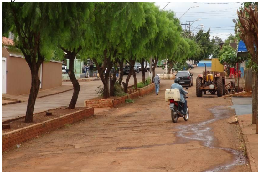
Figura 15 - Buracos nas ruas
