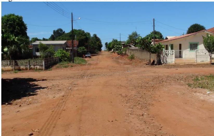
Figura 7 - Avenida e rua sem asfalto em Brasilândia do Sul
