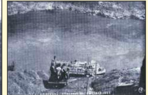
Funicular de 150 metros que resolveu o problema da atracação em Porto Mendes.
