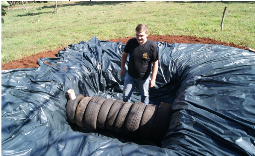
Figura 7: Construção da câmara de pneus. Instalar a tubulação de entrada no primeiro pneu para receber o efluente da caixa séptica
