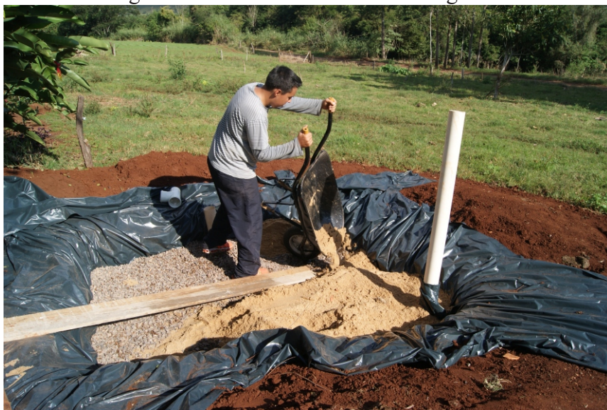
Figura 12: Preenchimento com areia grossa
