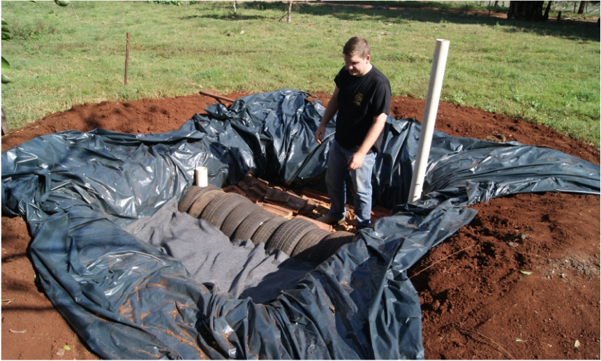
Figura 10: Instalação da manta geotêxtil no interior da BET
