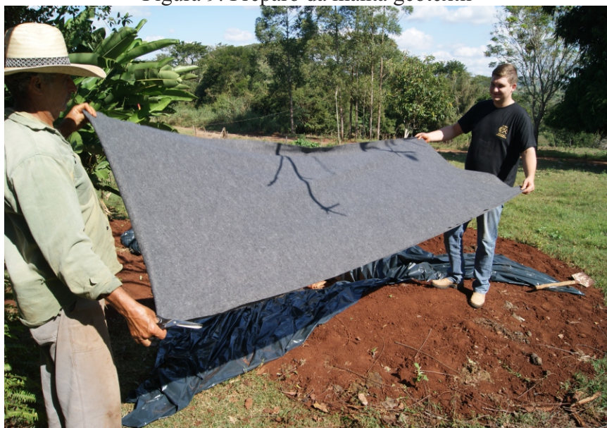
Figura 9: Preparo da manta geotêxtil
