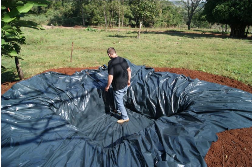
Figura 6: Impermeabilização da escavação com duas camadas de lona plástica
