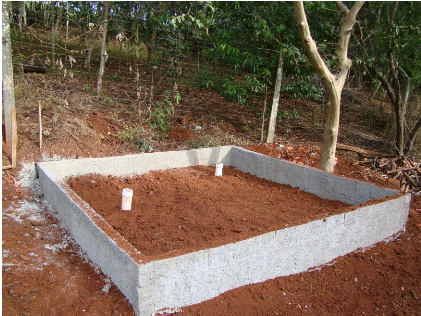
Figura 14: Mureta construída no entorno da BET e camada de solo
