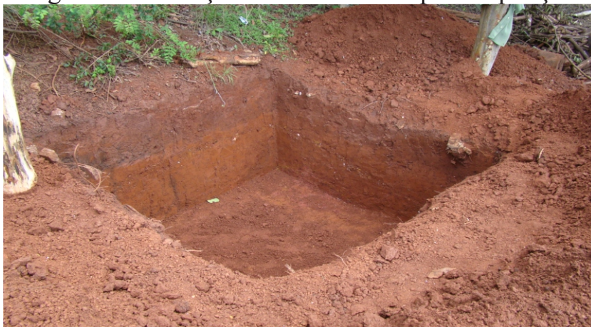
Figura 5: Escavação da Bacia de Evapotranspiração
