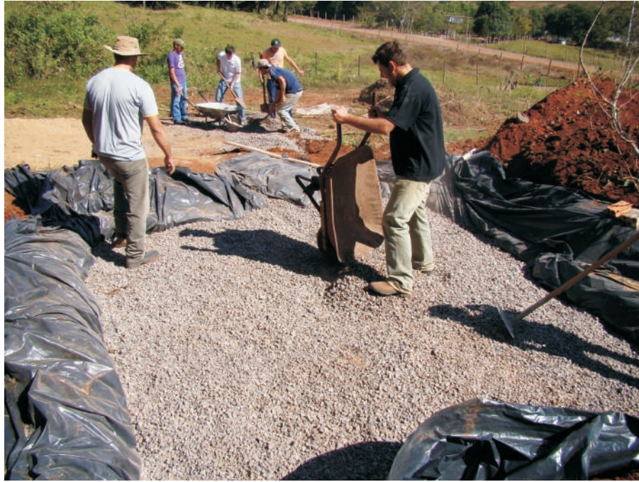
Figura 11 - Preenchimento da ETE com brita nº2.
