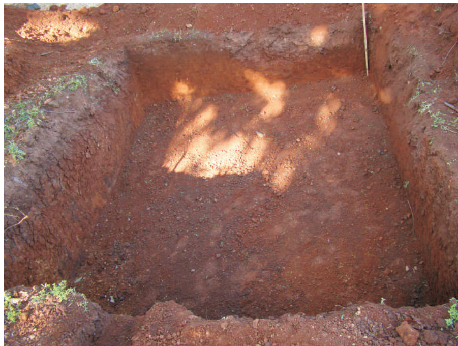
Figura 3 - Perfuração do Buraco.
