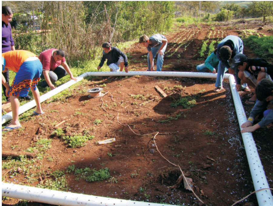
Figura 6 - Construção da tubulação interna.
